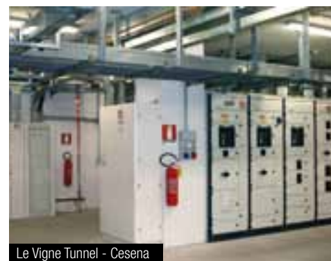
Le Vigne Tunnel - Cesena
